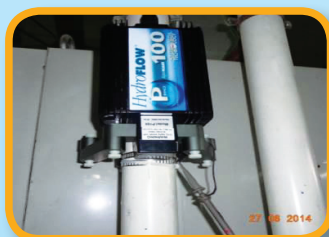
電磁波水垢清除系統安裝位置
